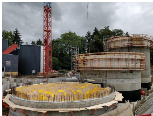
Trois nouveaux digesteurs
